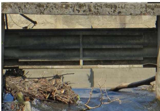
Corrosione ferro – derivazione del Lambretto
