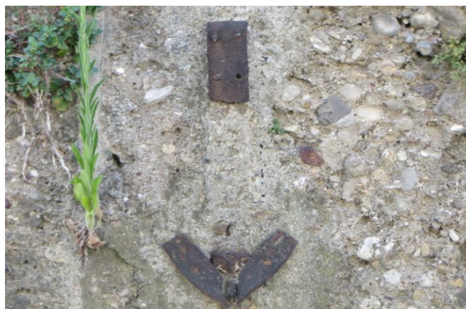
Corrosione ferro - Spalto Piodo
