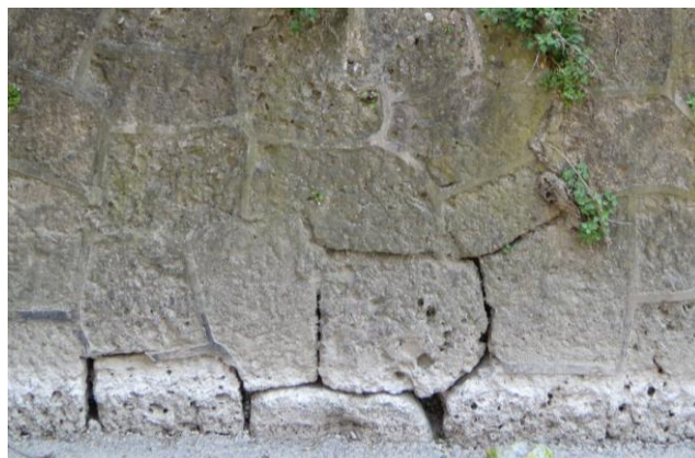
Efflorescenza ceppo lombardo - Spalto Piodo
