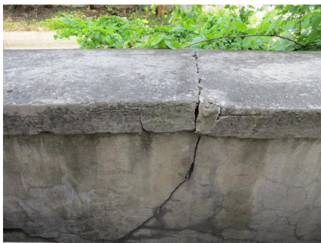
Fessurazione - Spalto Piodo
