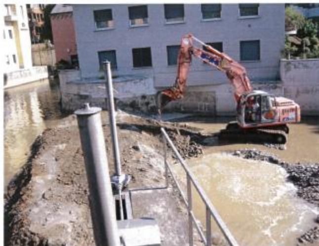
Traversa di via Aliprandi - Opere di jet-grounding, 2013
