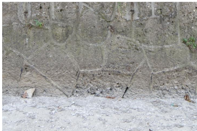
Erosione pietra e calcestruzzo-derivazione Lambretto Erosione ceppo lombardo - Spalto Piodo
