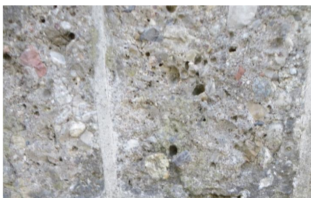
Degradazione differenziale ceppo lombardo - Spalto Piodo
