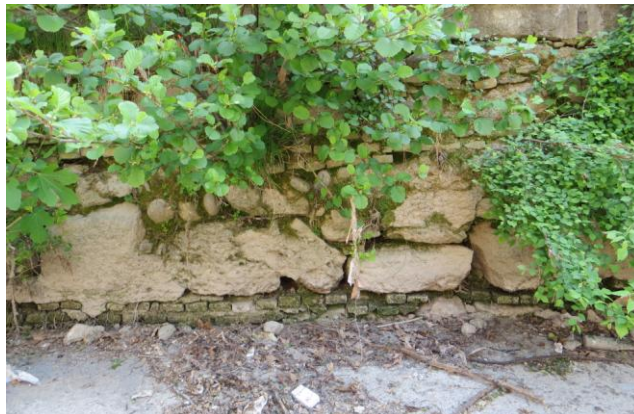
Disgregazione giunti di malta - Spalto Piodo
