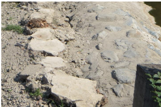
Erosione pietra e calcestruzzo-derivazione Lambretto Erosione ceppo lombardo - Spalto Piodo
