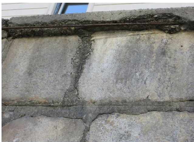
Carbonatazione cemento armato - Spalto Piodo
